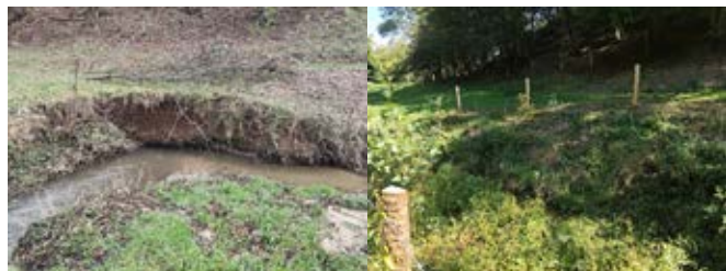
Gestion de l'érosion par des techniques de génie végétal sur le Coiset à Larajasse
